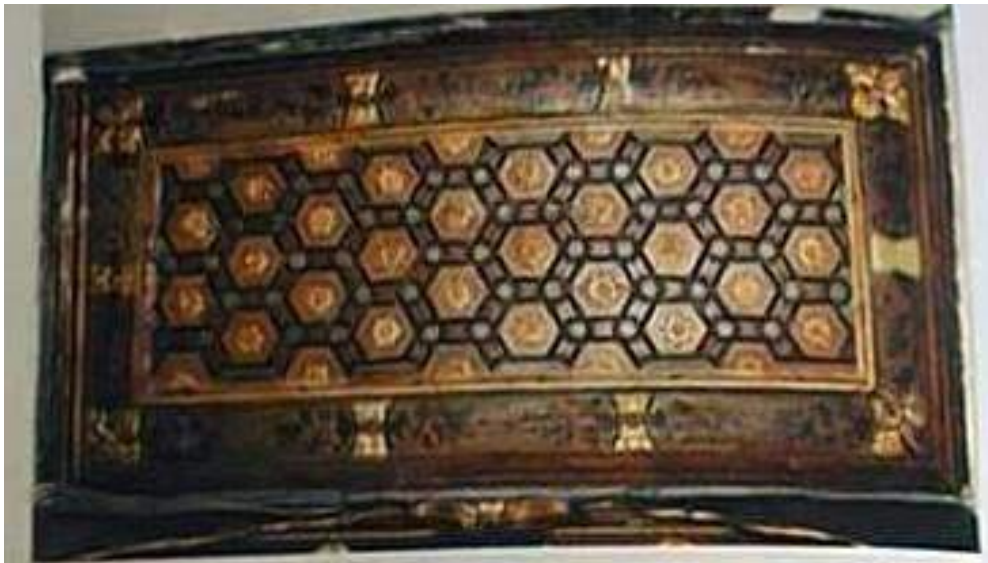
صورة 107 : قصر حسن باشا _ سقف _ النموذج الثاني _ الجزء الجنوبي _
