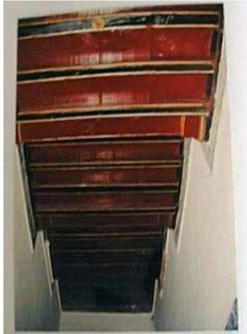
الصورة 115 : قصر الحمراء - سقف سلم -
