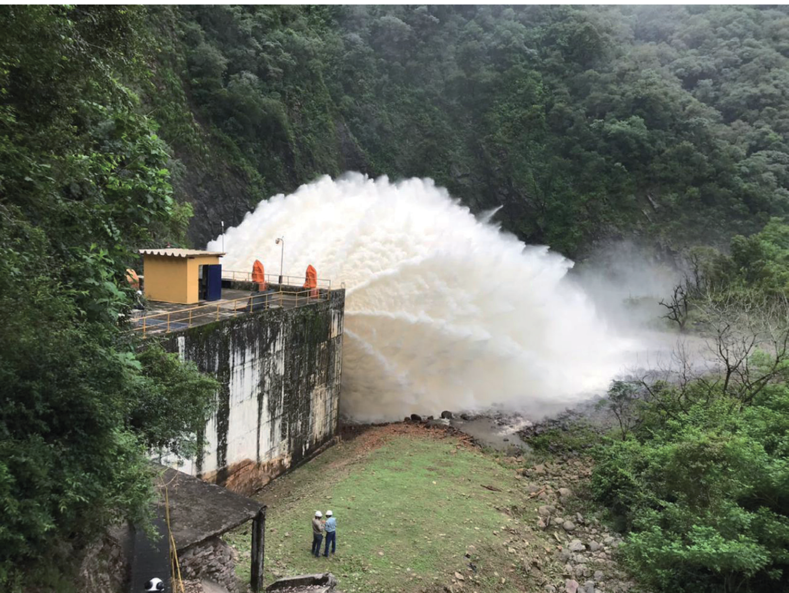
Figura 12. Descarga de fondo vista trasera en maniobra. Fuente: David G. Aguirre (2018).
