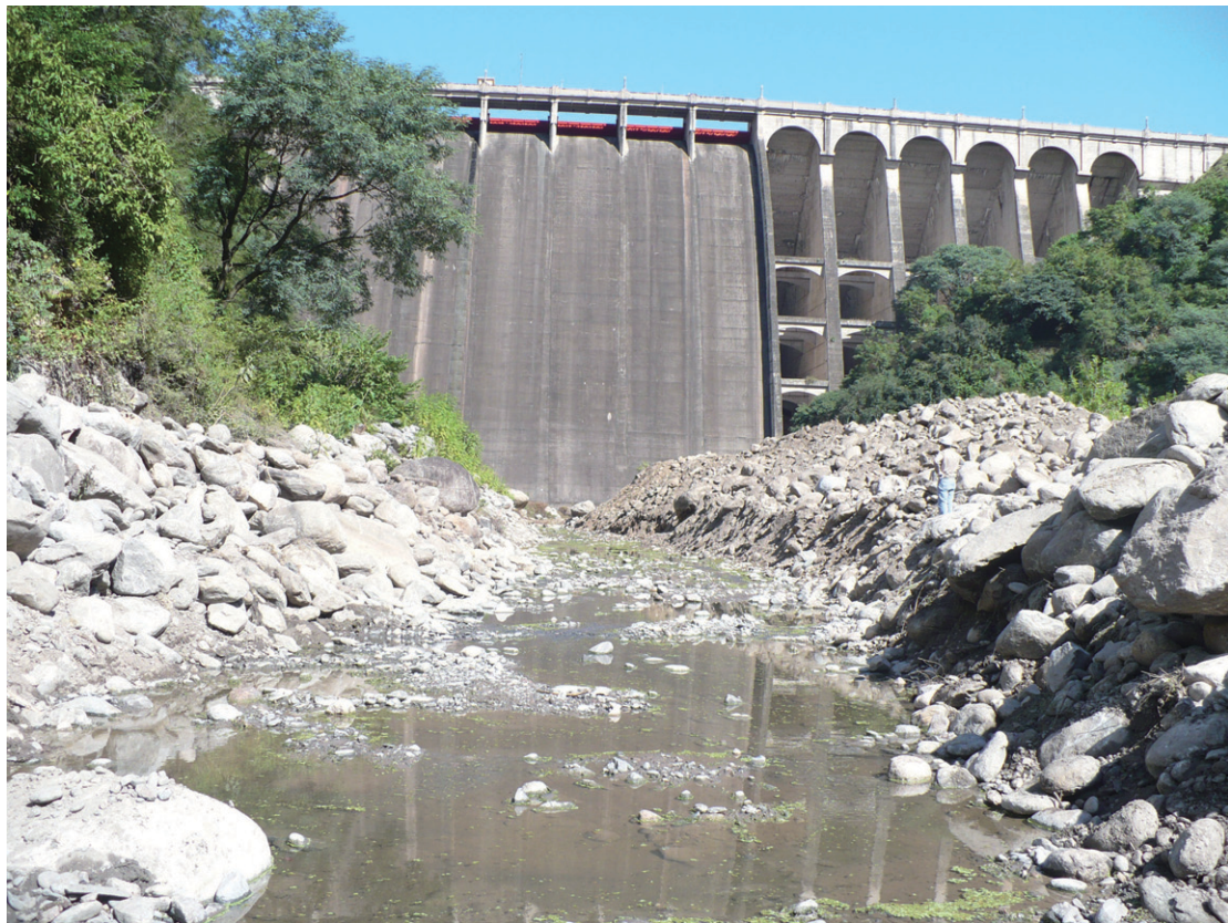
Figura 5. Vista frontal de aliviadero con perfil Creager. Fuente: David G. Aguirre (2018).
