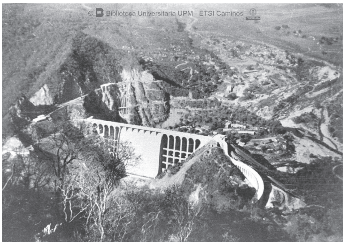
Figura 3. Embalse Escaba en su etapa final de construcción. Fuente: Ex Libris y Universidad Politécnica de Madrid (2007).
