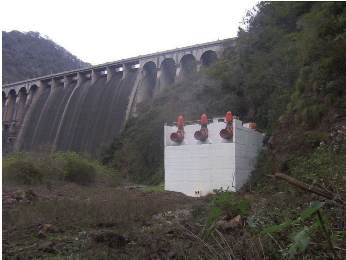
Figura 11. Descarga de fondo vista frontal. Fuente: David G. Aguirre (2018).
