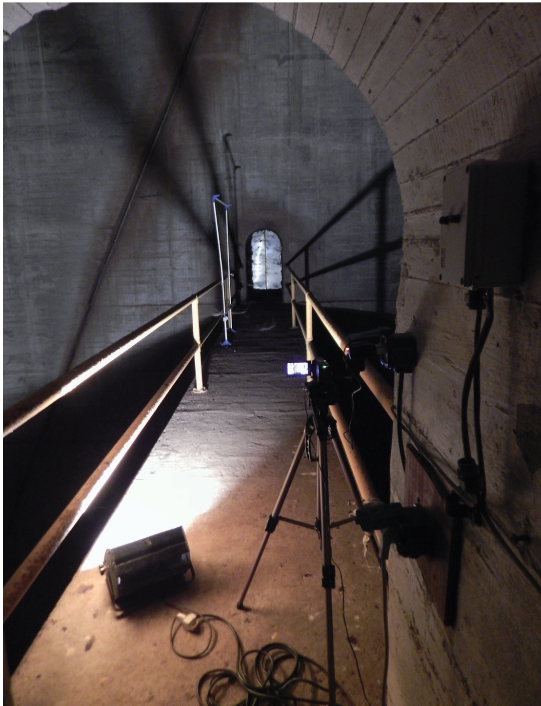
Figura 3. Cámara de video infrarroja colocada en la puerta del vano del dique.
