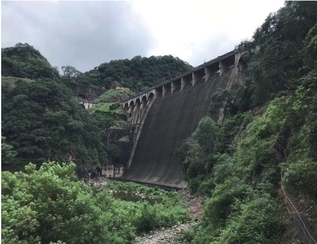
Figura 2. Vista desde lateral norte de la presa. Fuente: David G. Aguirre (2018).
