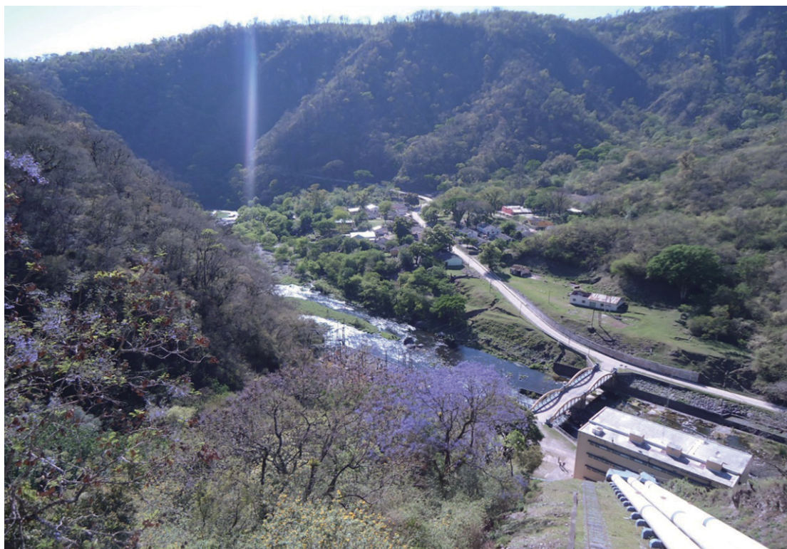
Figura 8. Tubería de conducción a central hidroeléctrica. Fuente: David G. Aguirre (2018).
