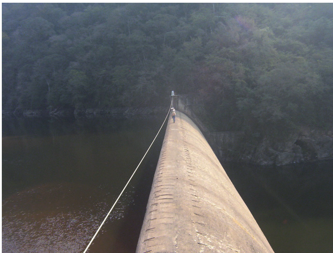
Figura 14. Vertedero de azud compensador Batiruana. Fuente: David G. Aguirre (2018).
