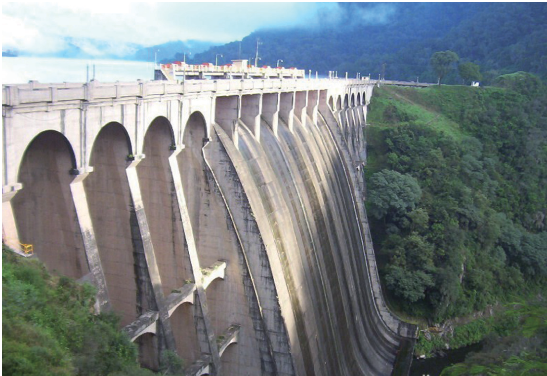
Figura 3. Vista desde lateral sur de la presa. Fuente: David G. Aguirre (2018).
