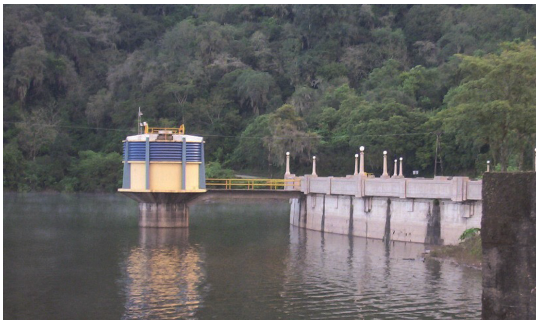
Figura 7. Toma de Riego y Descargador de fondo. Fuente: David G. Aguirre (2018).
